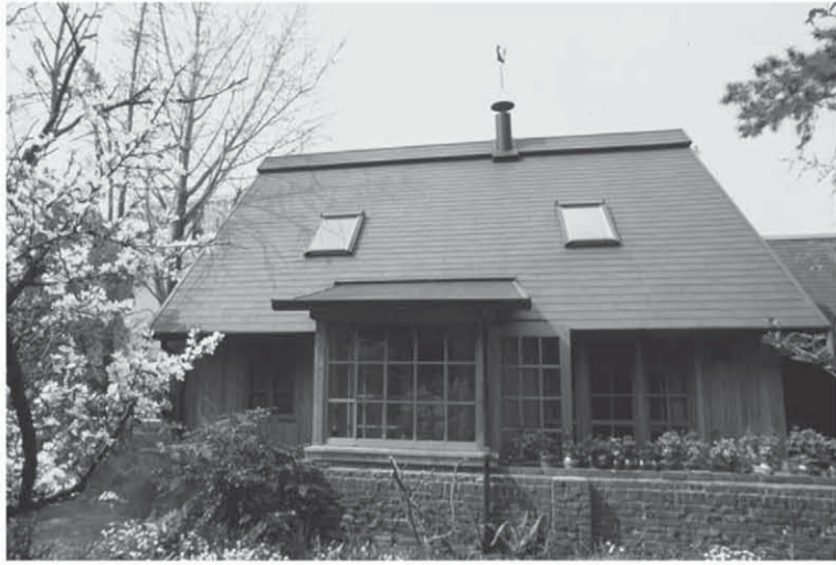
大屋根が印象的な神戸市東灘区の吉村邸の外観
